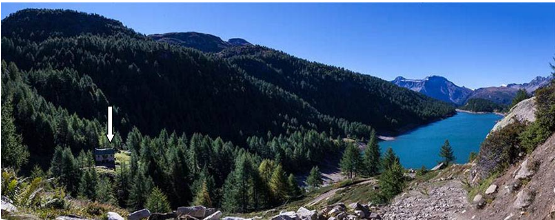
Foto 3: Edificio denominato Spigher utilizzato come cantinetta di stagionatura, posto in splendida posizione panoramica sopra al Lago di Devero. Sulla destra la pista che sale verso Canaleccio e alpe Forno
