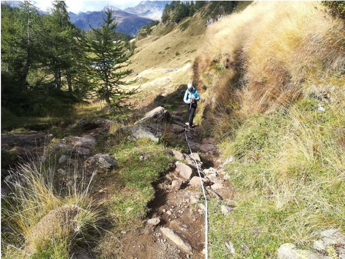
Foto 61: Intervento PT12. Tratta rocciosa da superare tramite una rampa in pietrame
