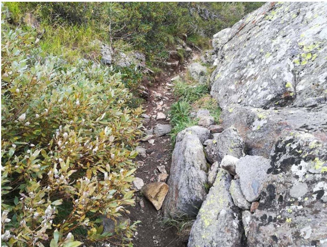
Foto 55: Intervento PT07. Trincea dal fondo roccioso da regolarizzare con posa di una pavimentazione grossolana in pietrame a riempire gli spazi vuoti
