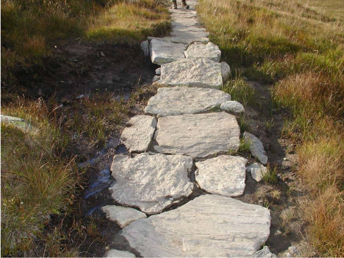
Foto 11: esempio di tipologia di intervento
