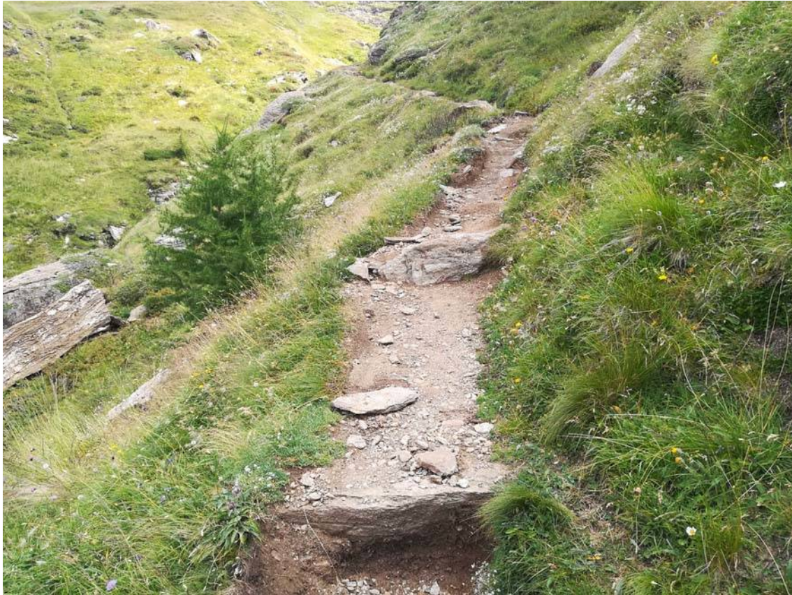
Foto 19: tratto a mezza costa esposto con numerosi ostacoli: da allargare verso monte e regolarizzare
