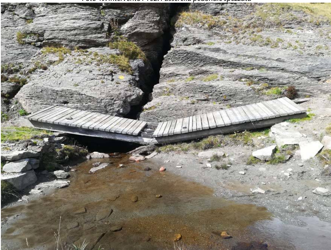
Foto 50: Intervento PT02. In sponda idrografica destra sarà costruita una nuova base d'appoggio in pietrame
