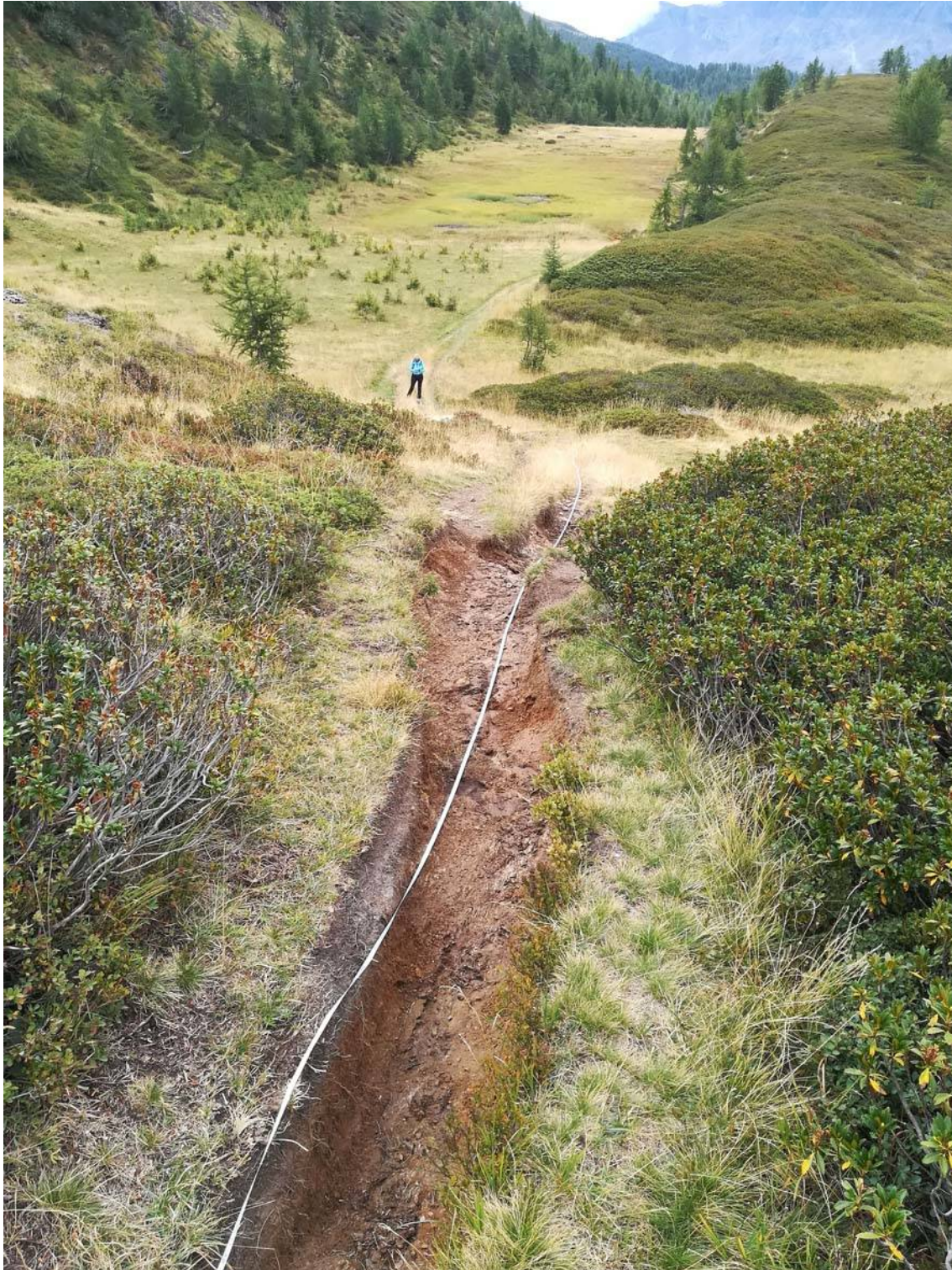
Foto 25: Intervento 16. Tratto di sentiero in trincea
