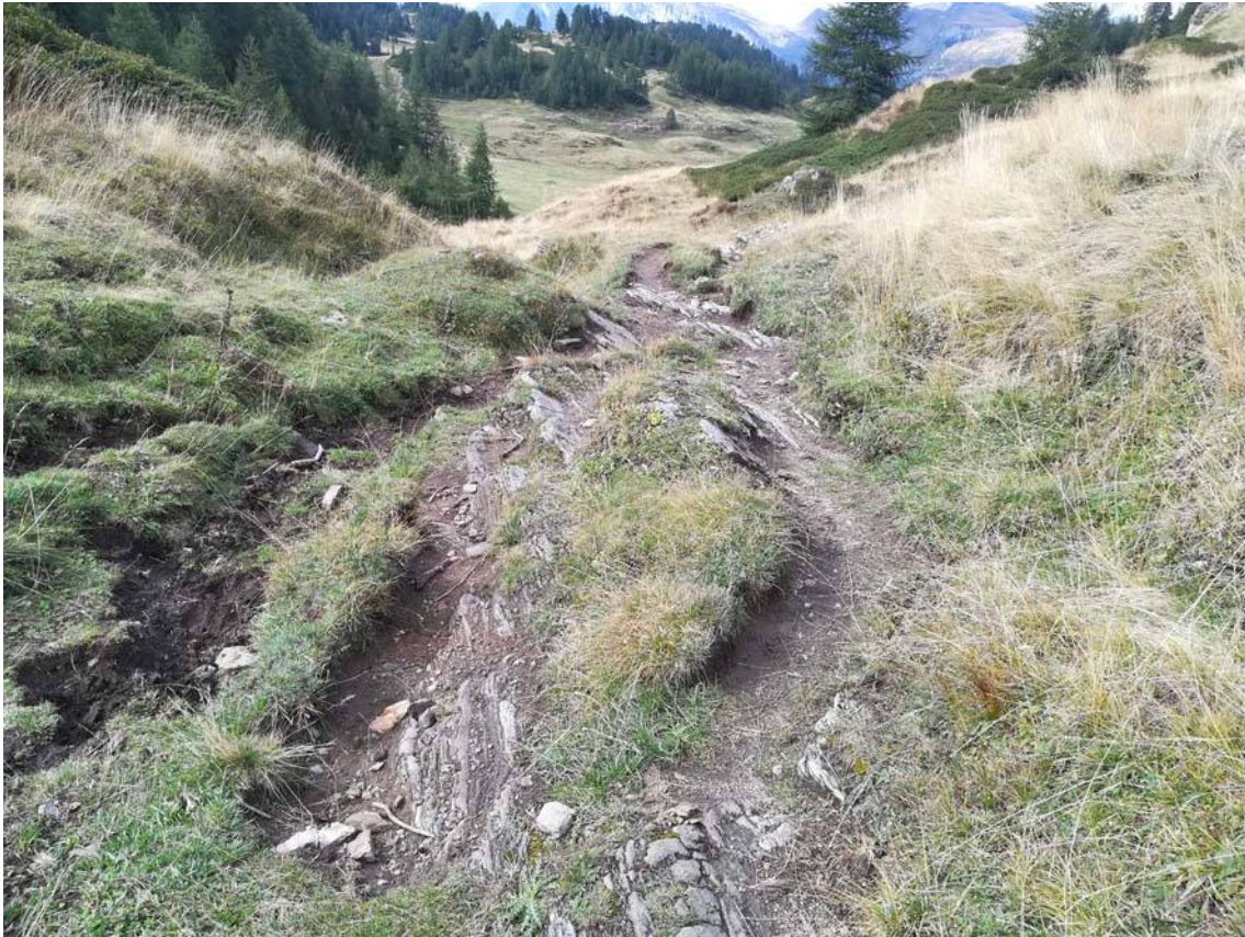
Foto 44: Intervento 23. Demolizione di alcune porzioni rocciose
