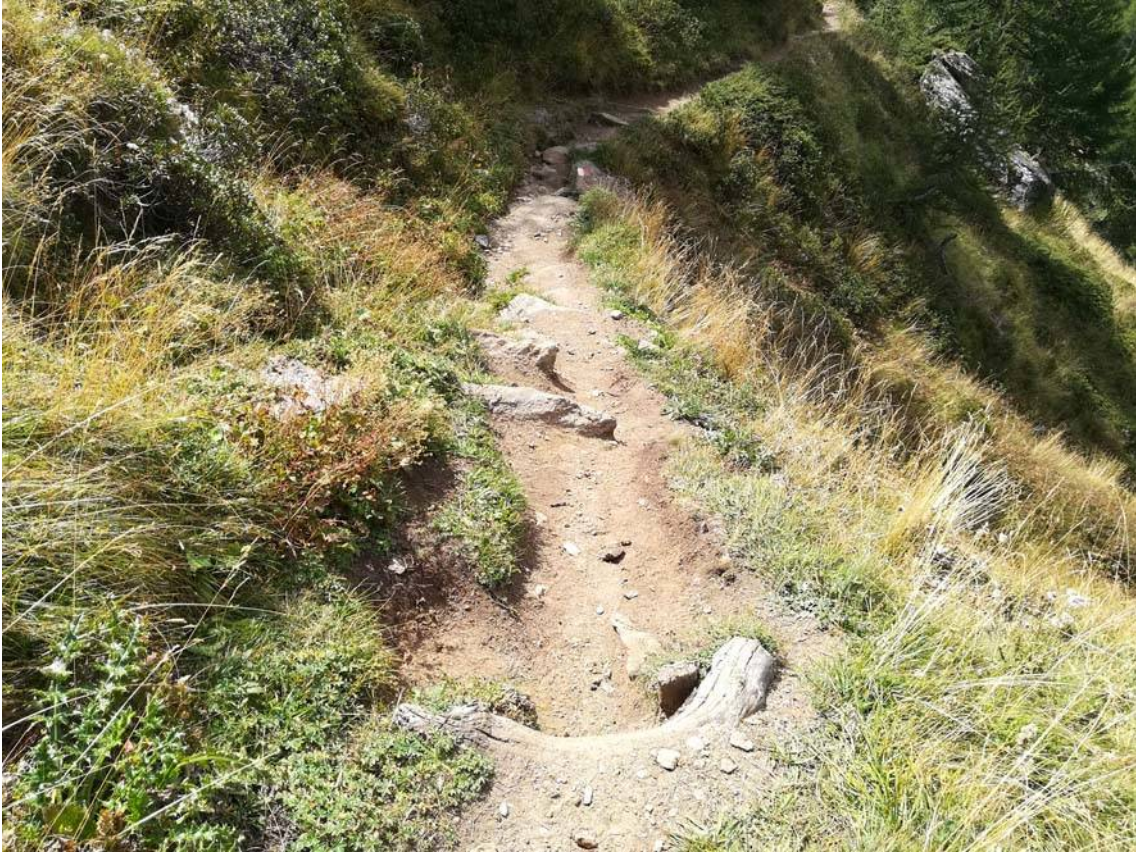
Foto 20: tratto a mezza costa esposto con numerosi ostacoli: da allargare verso monte e regolarizzare
