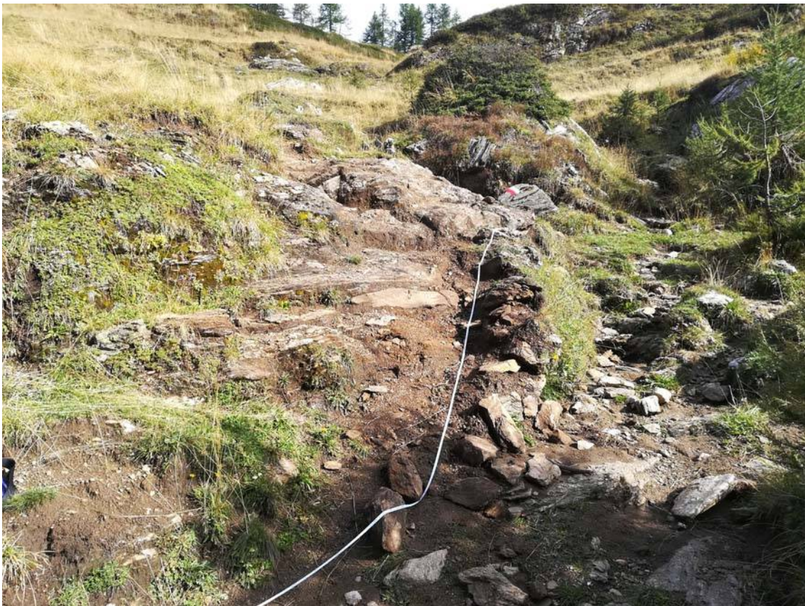
Foto 60: Intervento PT12. Tratta rocciosa da superare tramite una rampa in pietrame sostenuta da un muro in pietra
