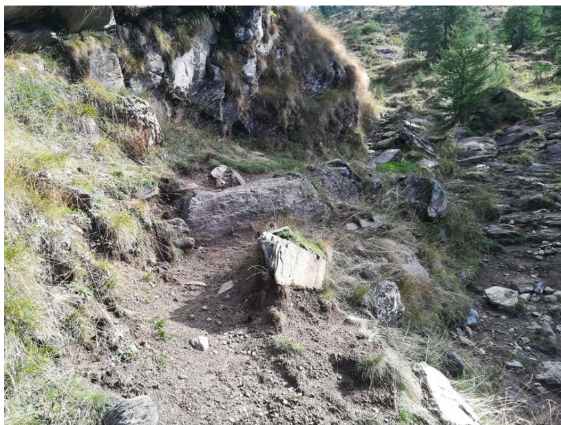
Foto 62: Intervento PT13. Alto gradino rocciosa da superare tramite una rampa in pietrame
