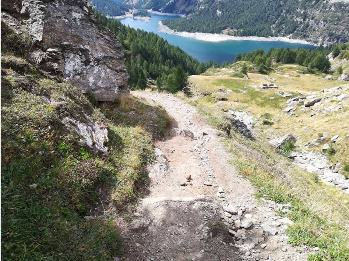
Foto 17: intervento lineare 8: tratto molto rovinato ed esposto dove si interverrà realizzando un tratto di lastricato
