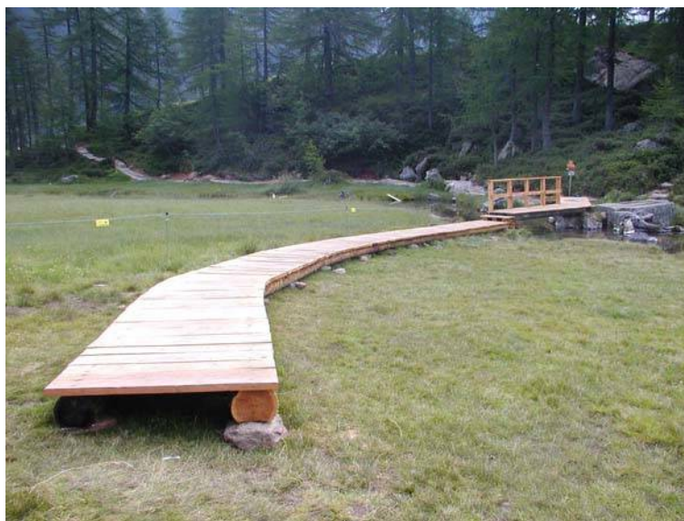
Foto 27: Intervento 16. Esempio di passerella per il superamento di una torbiera realizzata al Lago delle Streghe
